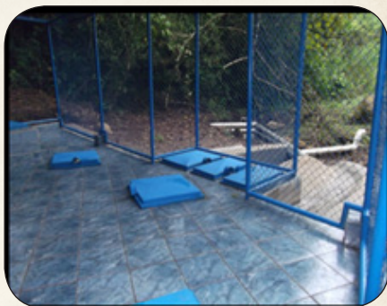
Naciente Bejarano Dicha naciente esta ubicada en Garabito, actualmente tiene un caudal de 38 litros por segundo de agua. Abastece los tanques de San Gerardo; que a su vez abastecen la mayoría de la población del centro de Aguas Zarcas
