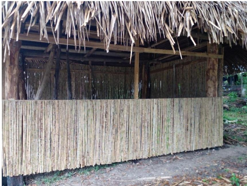
*Ilustración 14. Pegar las paredes es un proceso lento*
