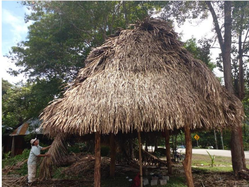
*Ilustración 13. Palma a palma, se termina de hacer el techo*
