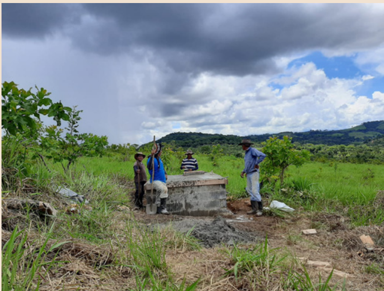
Fotografía 2. Mejoramiento de acueducto comunitario en San Andrés de Térriba
